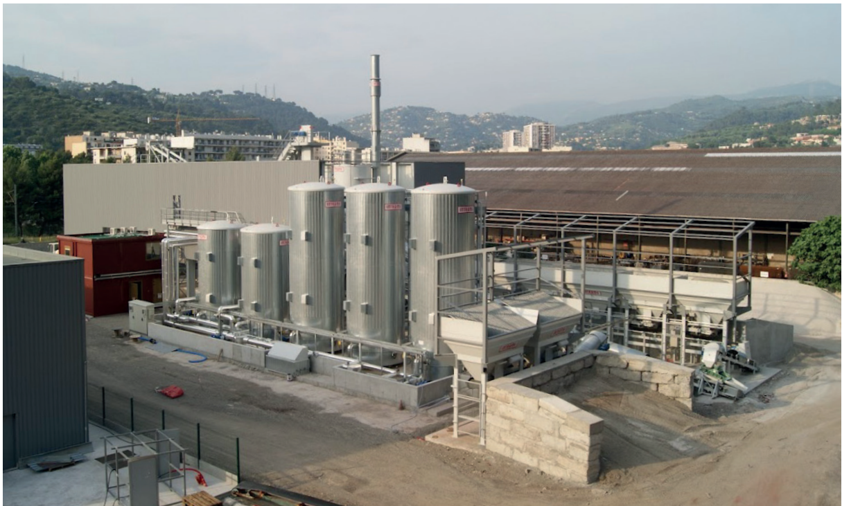
Planta asfáltica de 120 t/h con torre mezcladora InNOVA-S especial (sin criba) encerrada parcialmente en un recinto metálico. Con equipo de reciclado en frío con descarga en el mezclador. Tanques de asfalto, emulsión y betún fluxado con calentamiento eléctrico. Mezclador de 1.500 kg. Instalada en Niza (Francia).
