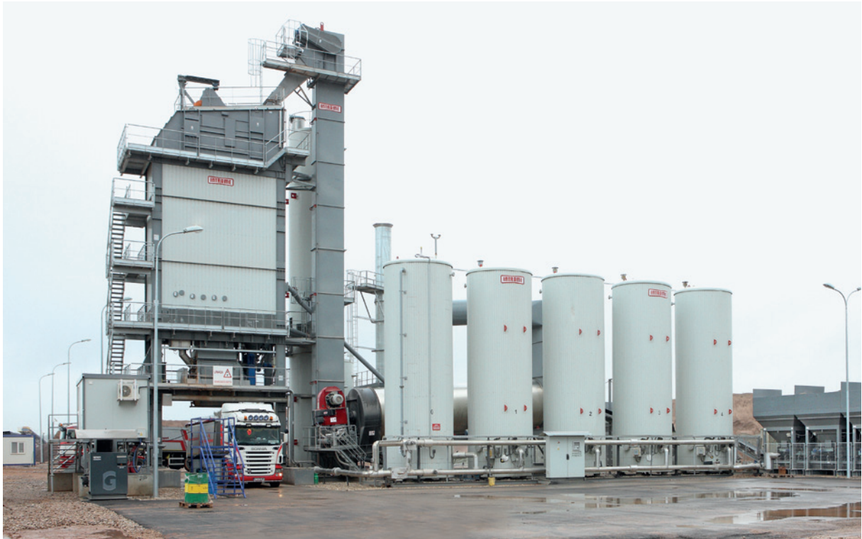
Planta asfáltica de 320 t/h (Polonia). Con torre mezcladora InNOVA-G con tolvas en caliente de 160 t. Tanques de asfalto con calentamiento eléctrico. Instalada sobre cimentaciones metálicas. Mezclador de 4.500 kg.
