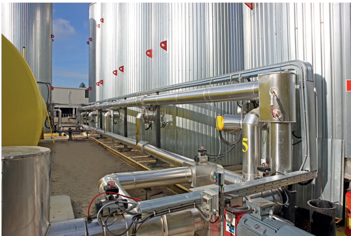
Tuberías con calentamiento eléctrico en planta InNOVA 320 (Polonia).
