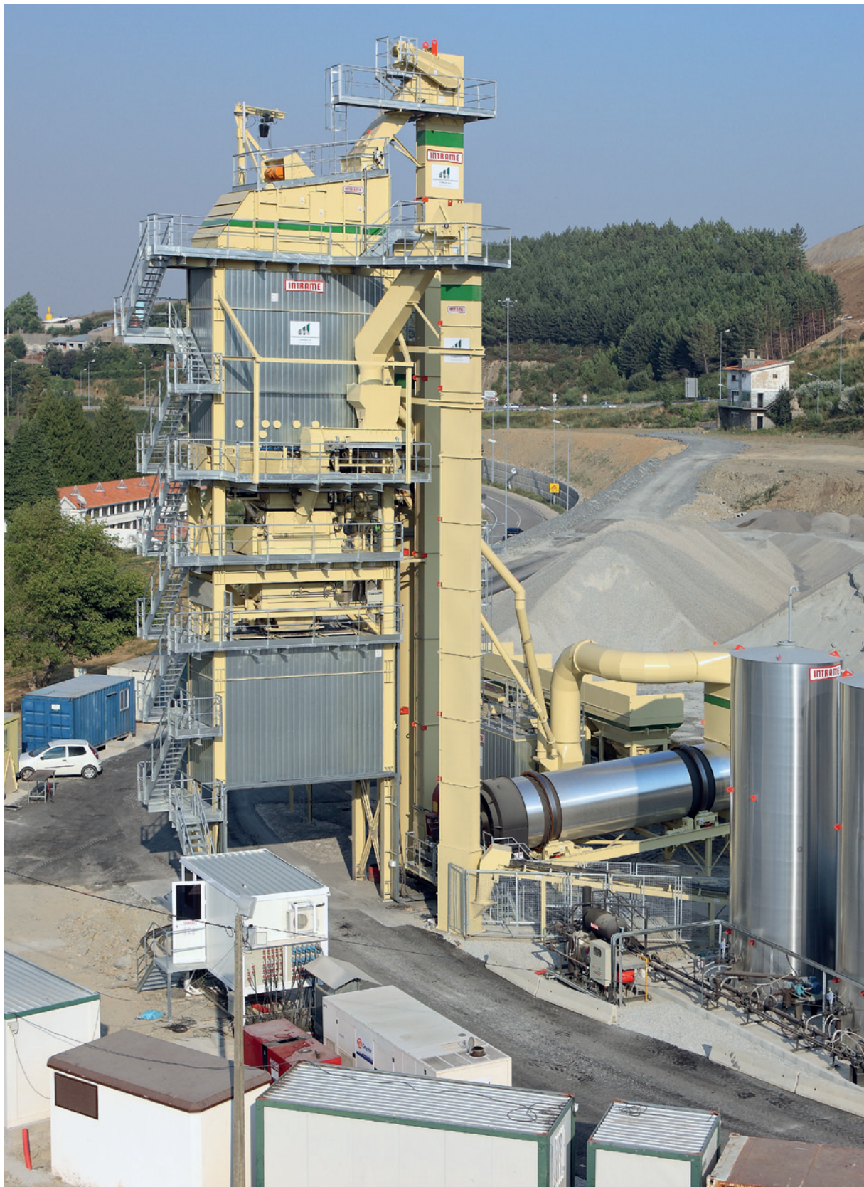
Planta asfáltica de 200 t/h (Portugal). Con torre mezcladora InNOVA-S. Con tolvas en caliente de 90 t y silo de aglomerado de 57 t. Mezclador de 2.500 kg. Provista de equipo de reciclado en frío con descarga en el mezclador.
