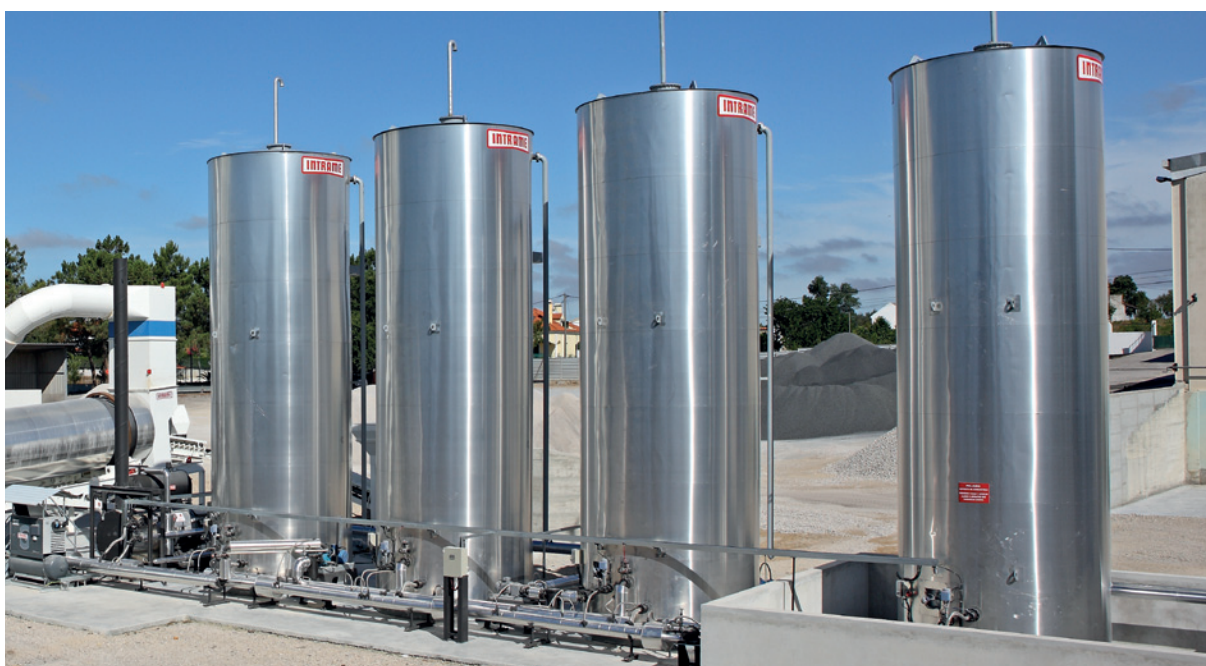
Tanques verticales con calentamiento por aceite térmico.
